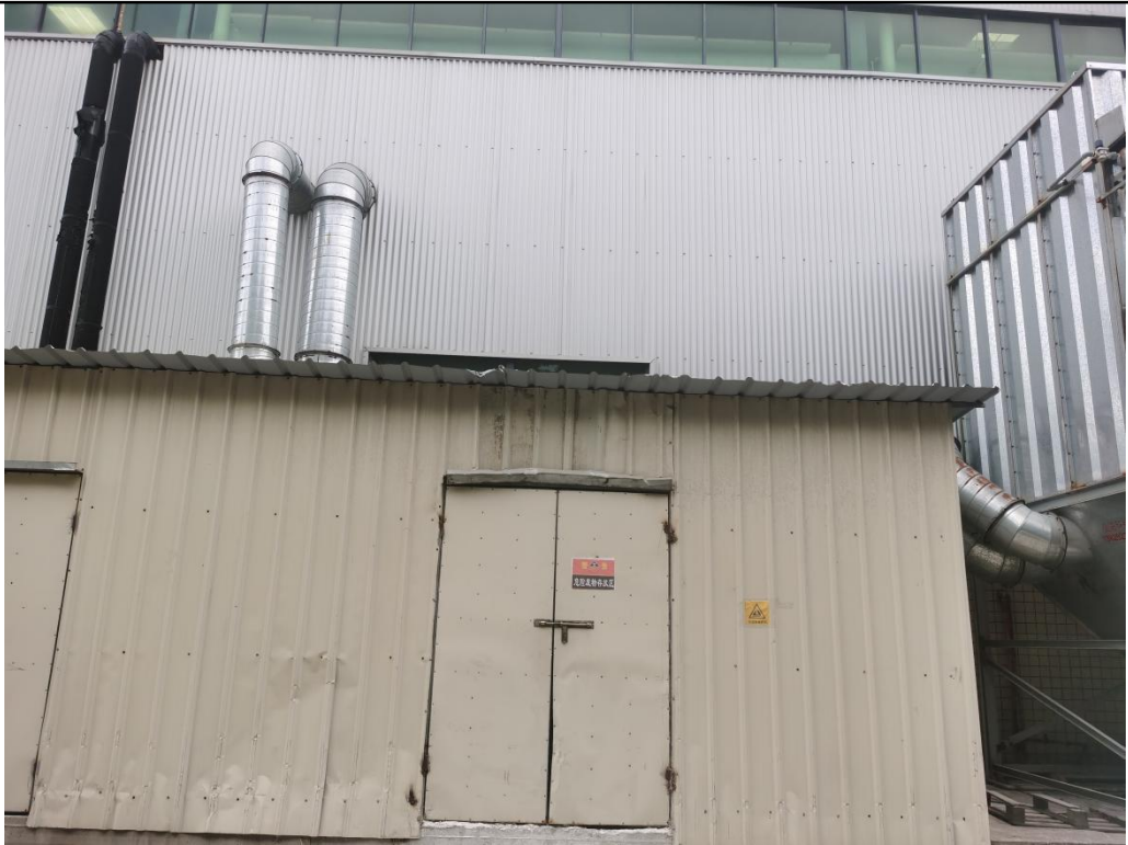
项目危废暂存间
