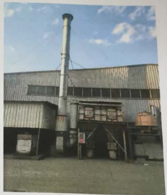
图4-2 粉尘废气集气装置及处理设施现场照片
